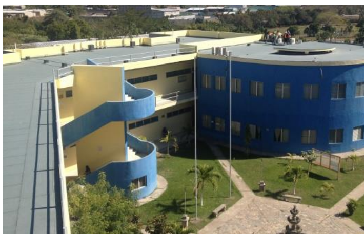
Obra finalizada en Edificio Principal
