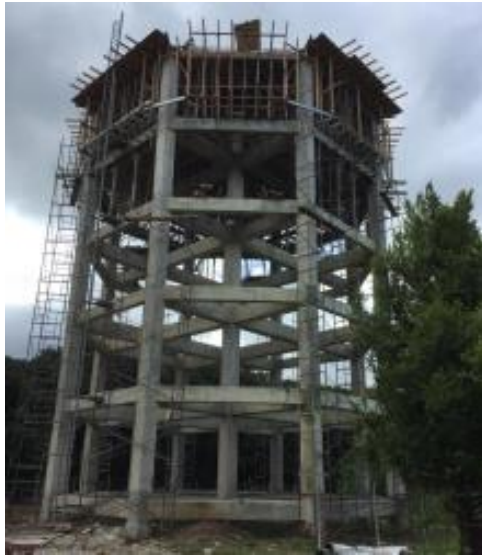
Avance en construcción del tanque
