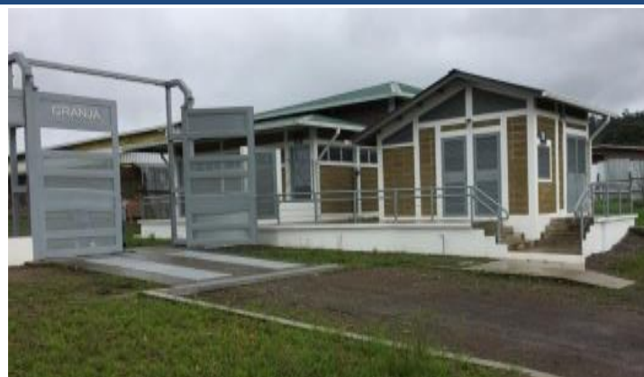
Vista de Garita, acceso principal y control de equipo
