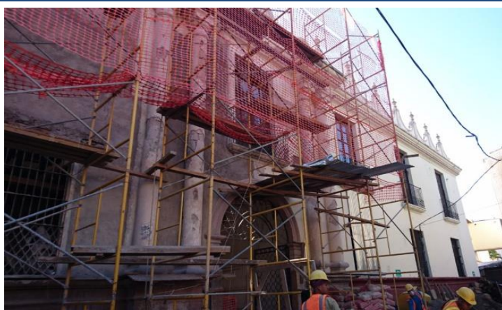
Vista fachada principal, Avance de obra
