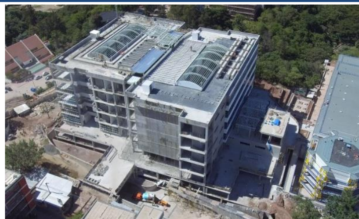
Vista aérea noreste del Edificio 1847
