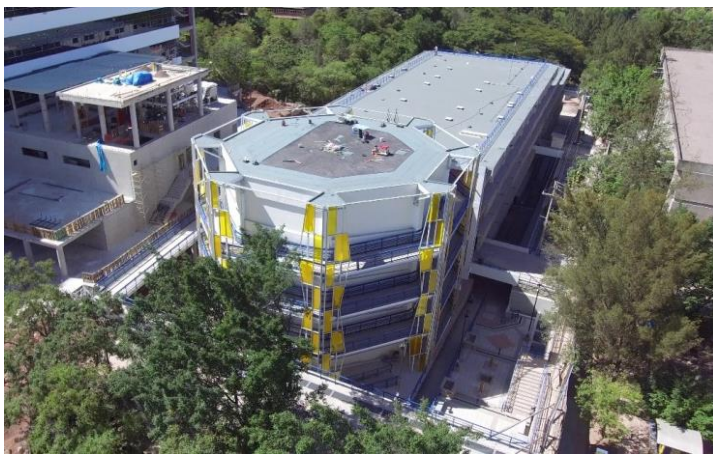
Vista aérea noreste del Edificio
