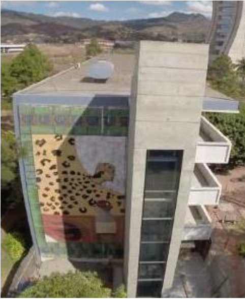
Elevado Edificio A1
