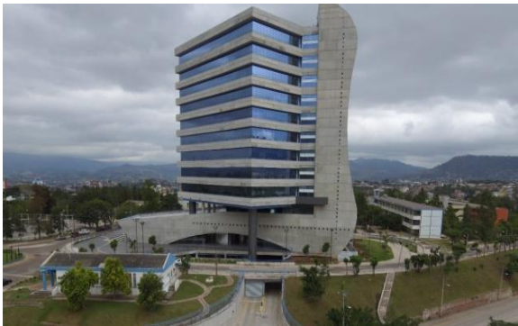
Vista ala Este del edificio
