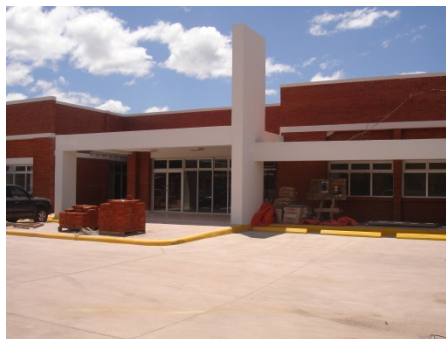
Acceso principal del Edificio
