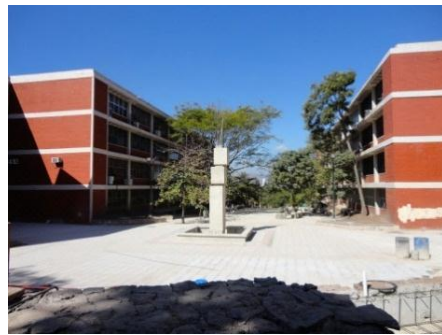
Vista panorámica de la plaza ubicada entre los Edificios 4A y 4B
