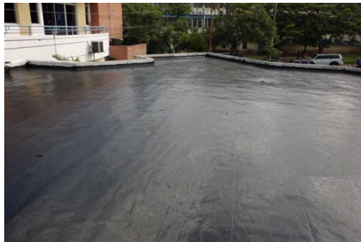
Acabado final de Impermeabilización Azotea Edificio VOAe y Azotea Edificio L-1
