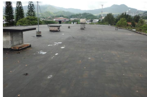
Acabado final de Impermeabilización Azotea Edificio VOAe y Azotea Edificio L-1
