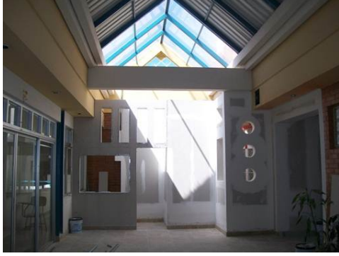
Vista Interior de la obra finalizada primer nivel
