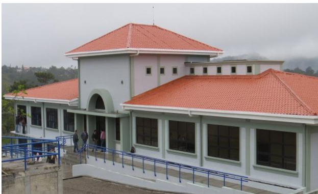
Fachada Principal Edificio
