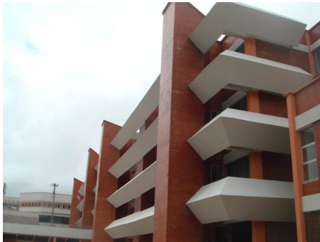
Vista de la obra finalizada
