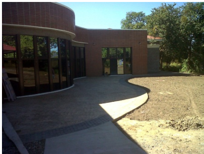
Vista de la Fachada Principal del Edificio
