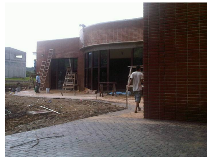
Vista durante el proceso de Construcción.
