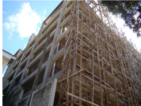
Vista mostrando el avance de la obra en construcción
